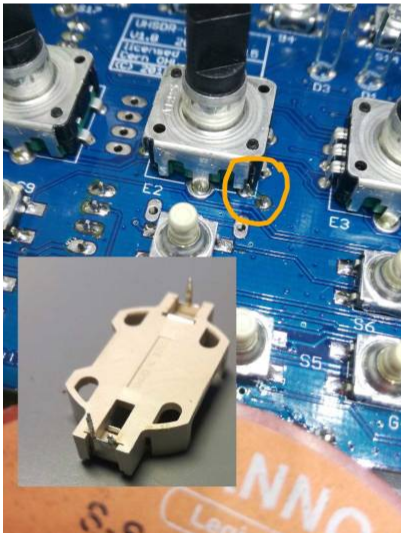
Möglicher Kurzschluß (photo DF9EH)
